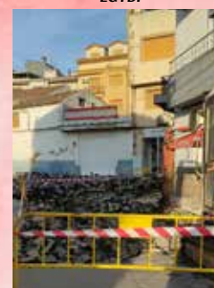
Arreglo y nuevo acerado en Avda. Juana I
