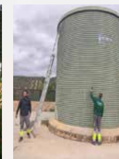
Reparación del depósito de las cubas
