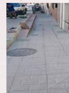
Arreglo de callejón en calle Arroyo
