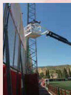
Mejora de instalaciones deportivas
